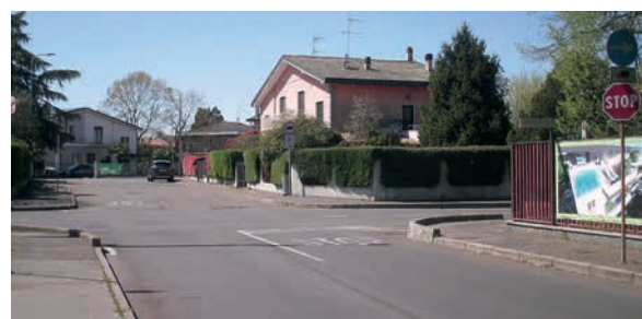
L'incrocio prima del restringimento stradale
