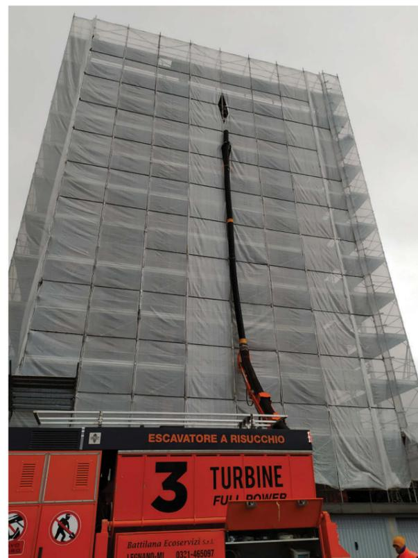
nelle cantine. La maggior parte dei condòmini ha optato anche per la sostituzione dei serramenti. In un edificio dove circa il 55% dell'energia termica prodotta veniva sprecata, si arriverà ad una riduzione del fabbisogno del 65%, con il salto di ben 4 classi: da una Classe Energetica D (fabbisogno annuo di energia 142,30 kWh/m<sup>2</sup>) a una Classe A2 (fabbisogno annuo di energia 49,86 kWh/m<sup>2</sup>).
