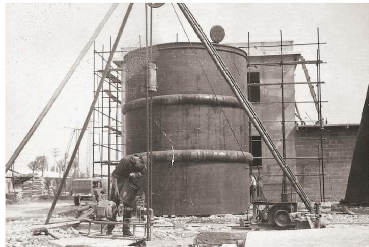
Industria UNION di Caleppio di Settala 1962-1963. Con battipalo elettrico e compressore per lo spurgo installazione di un pozzo d'acqua con tubazione in ferro zincato di 3" innestato nel terreno, più acquedotto
